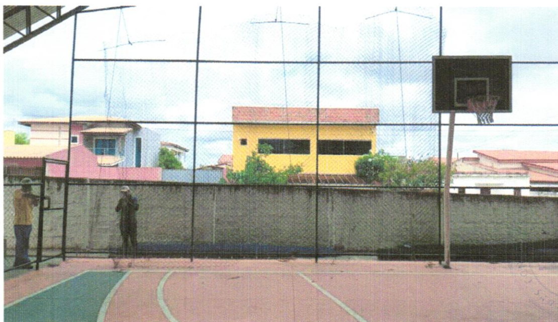
Foto 08 – INSTALAÇÃO DE ALAMBRADO FUNDO
