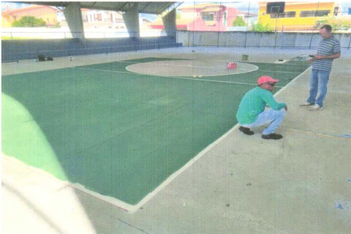
Foto 05 – DEMARCAÇÃO E PINTURA DO PISO DA QUADRA
