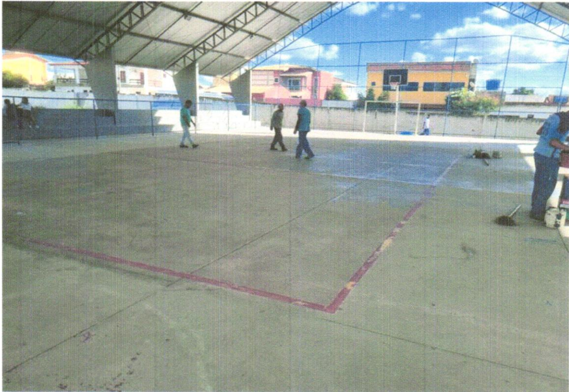
Foto 03 – DEMARCAÇÃO PARA PINTURA DO PISO DA QUADRA
