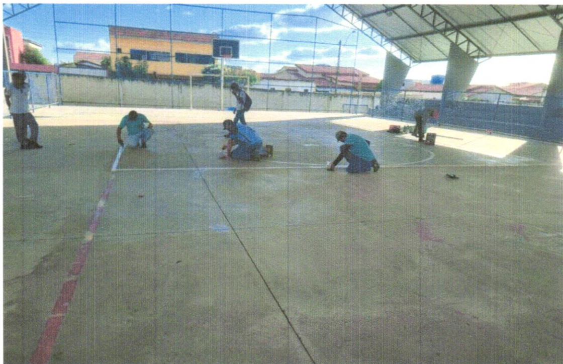
Foto 04 – DEMARCAÇÃO PARA PINTURA DO PISO DA QUADRA
