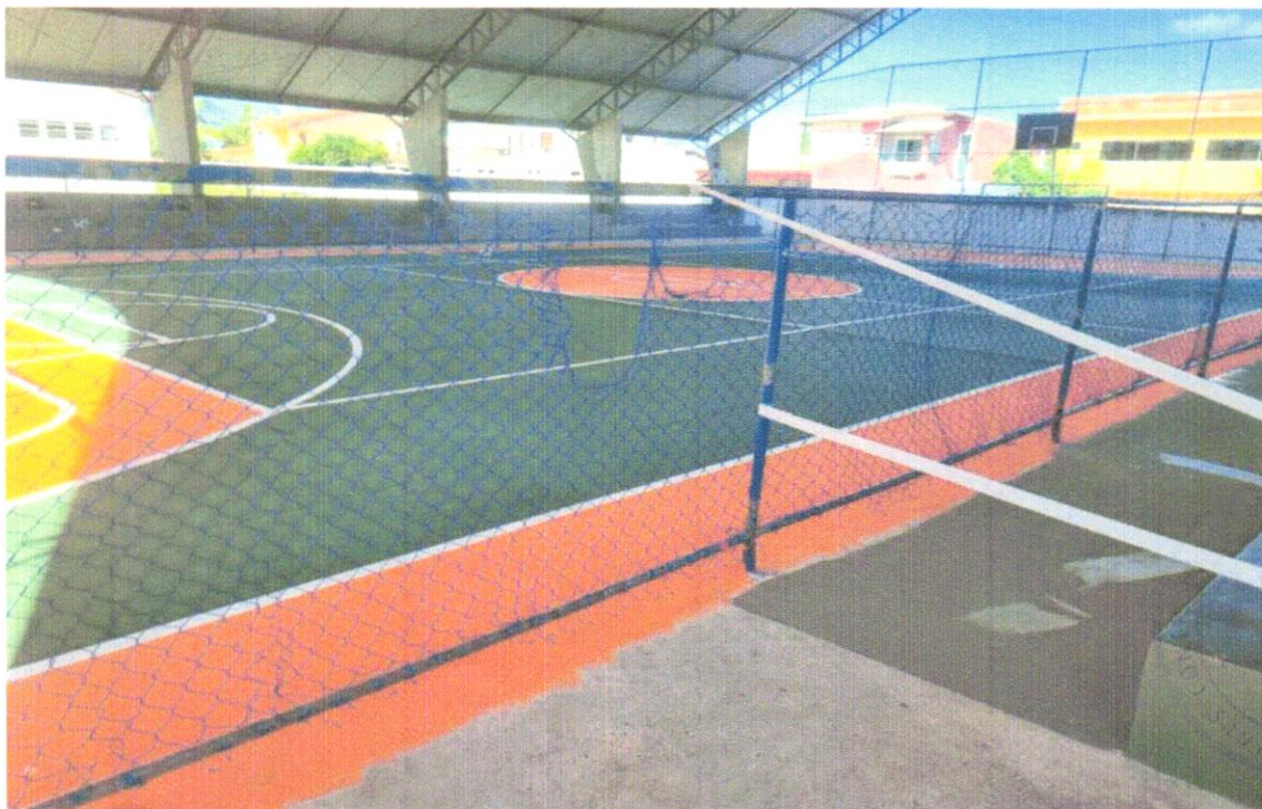
Foto 06 – PINTURA DO PISO E ARQUIBANCADA
