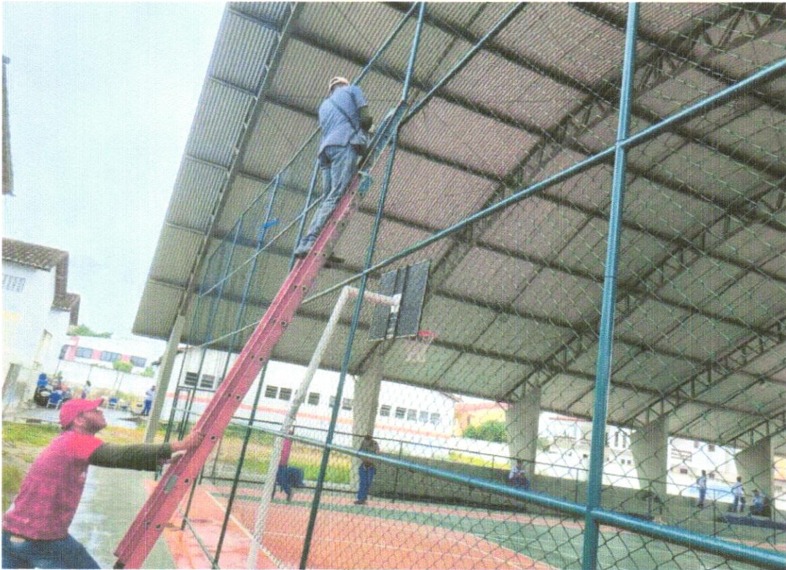
Foto 09 – INSTALAÇÃO DO ALAMBRADO FRONTAL
