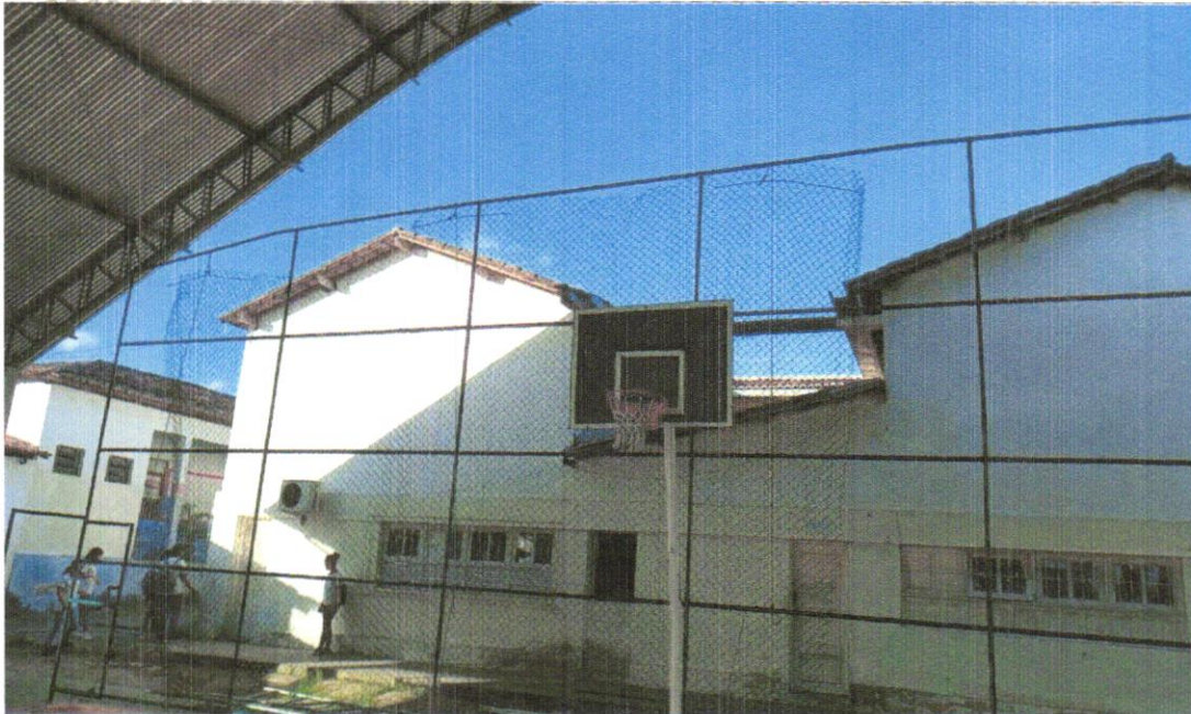
Foto 01 – REMOÇÃO DE ALAMBRADO FRONTAL
