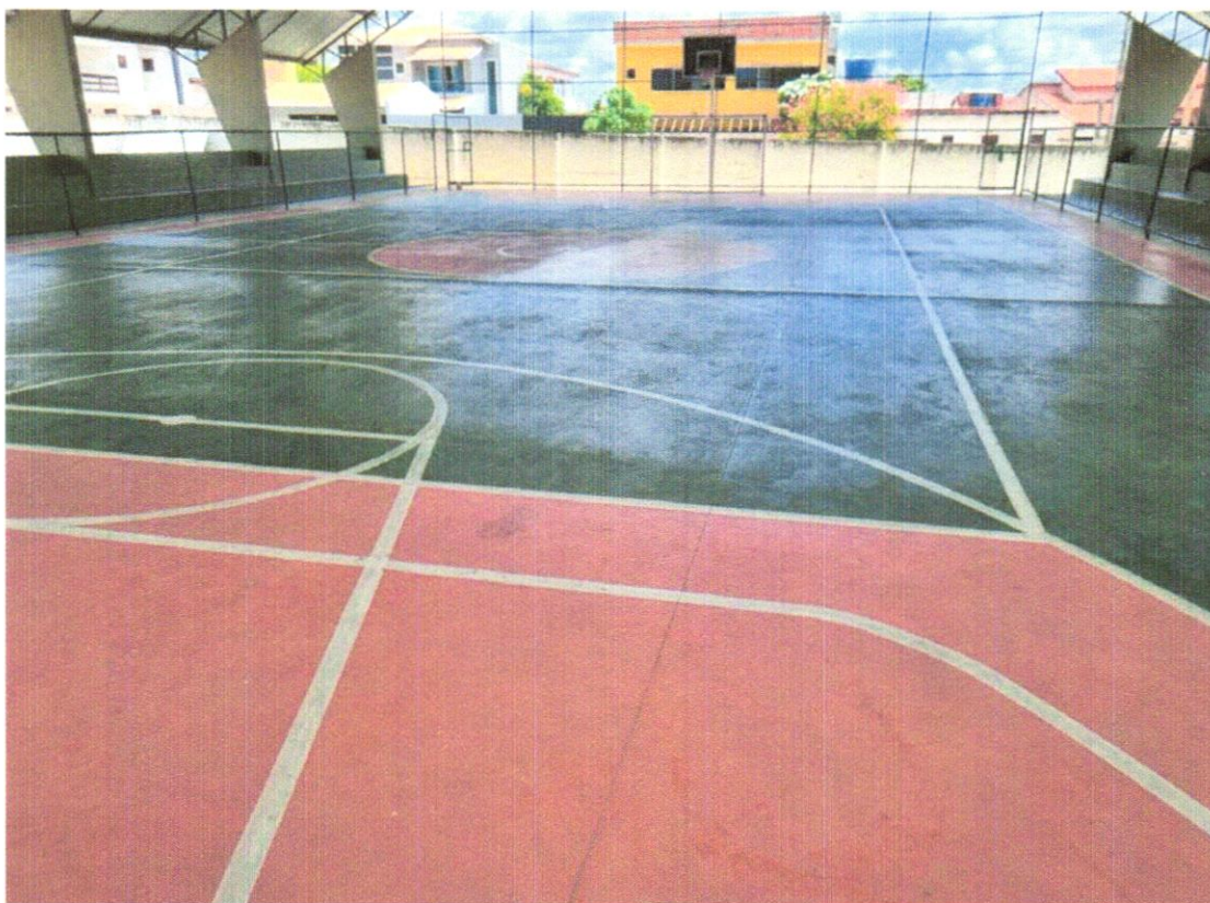
Foto 07 – PINTURA DO PISO DA QUADRA
