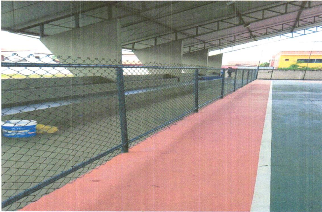
Foto 11 – INSTALAÇÃO DO ALAMBRADO LATERAL
