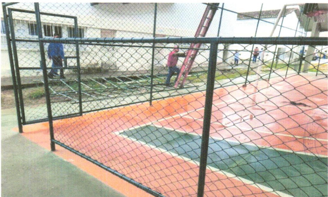
Foto 10 – INSTALAÇÃO DO ALAMBRADO LATERAL
